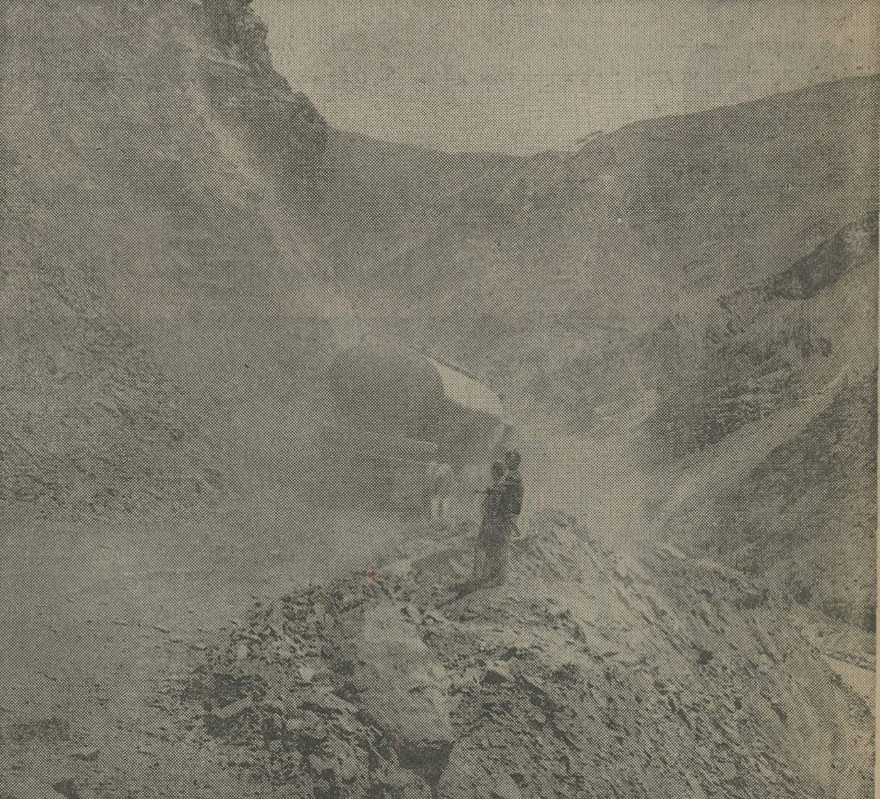
ریزش کوه دره هراز بواسطه موقعیت جغرافیایی خاص بر روی توده های از سنگهای آذری نباشده است. بهین جهت پایه های جاده سست است و هر چند وقت ریزش کوه در این جاده حادثه می آید این عکس چندی قبل درست هنگام ریزش قسمتی از کوه که بر اثر عبور کامیون بوجود آمده تهیه شده است.
