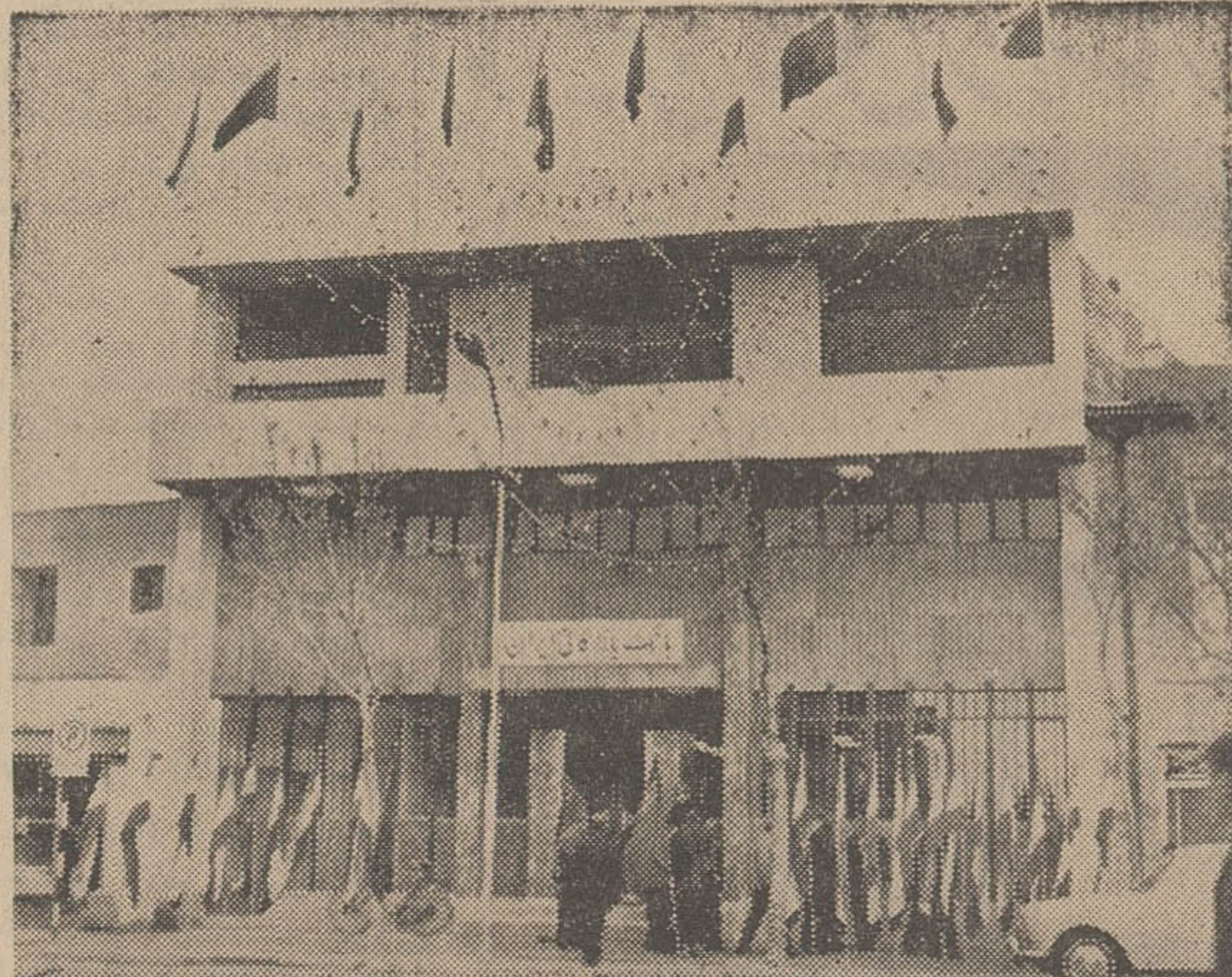
نمای خارجی ساختمان بانک بازرگانی
