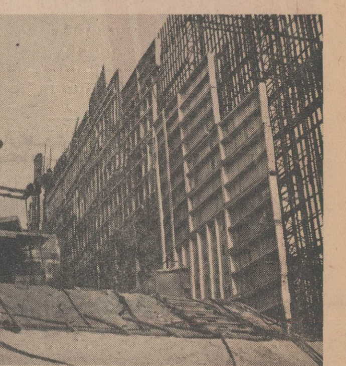
کف دریچه سرریز و دیواره آن و دیوار پائین دست
