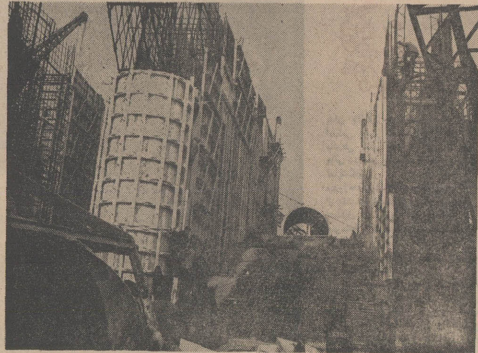
نمای دیوارهای دریچه‌های سرریز در پائین دست
