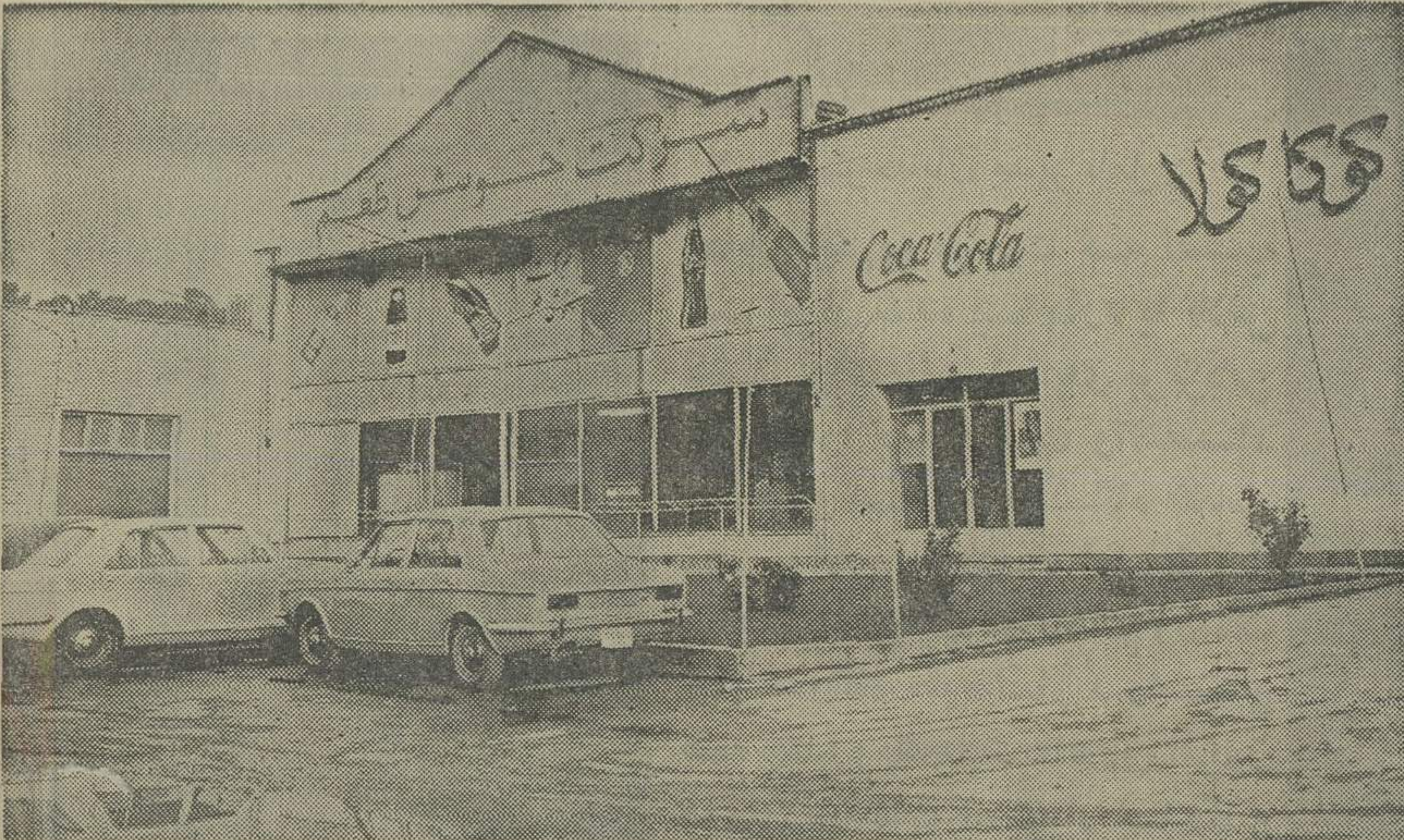
نمای خارجی کارخانه خوش طعم (کوکاکولا و کانادادرای) اصفهان
