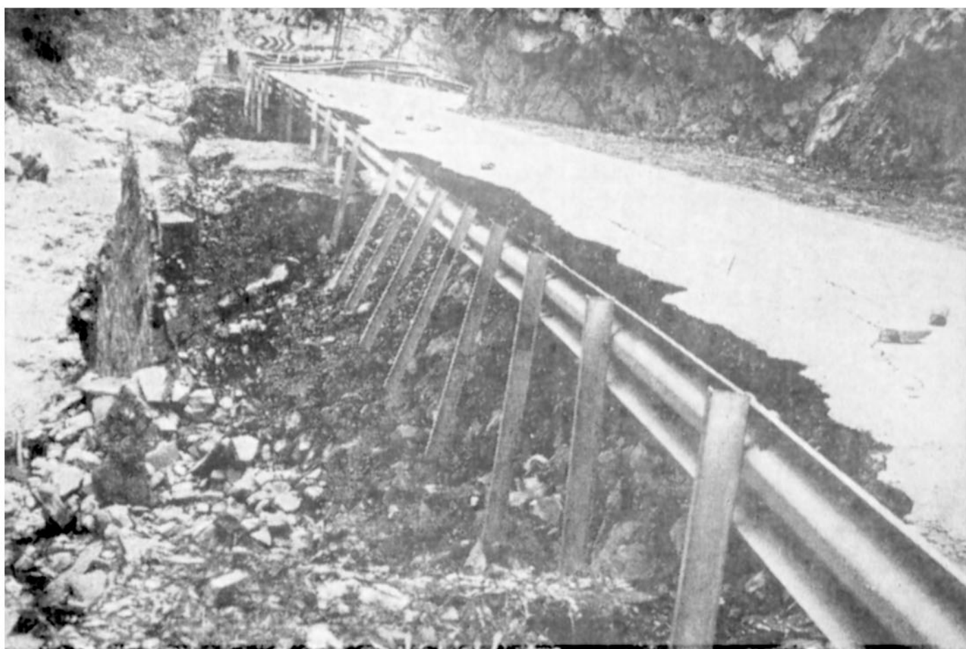
یک قسمت از جاده چالوس کسب اسفالت آن را شش ماه ازین برده است . نظیر این خرابی در بخش بزرگی از جاده دیده میشود.
