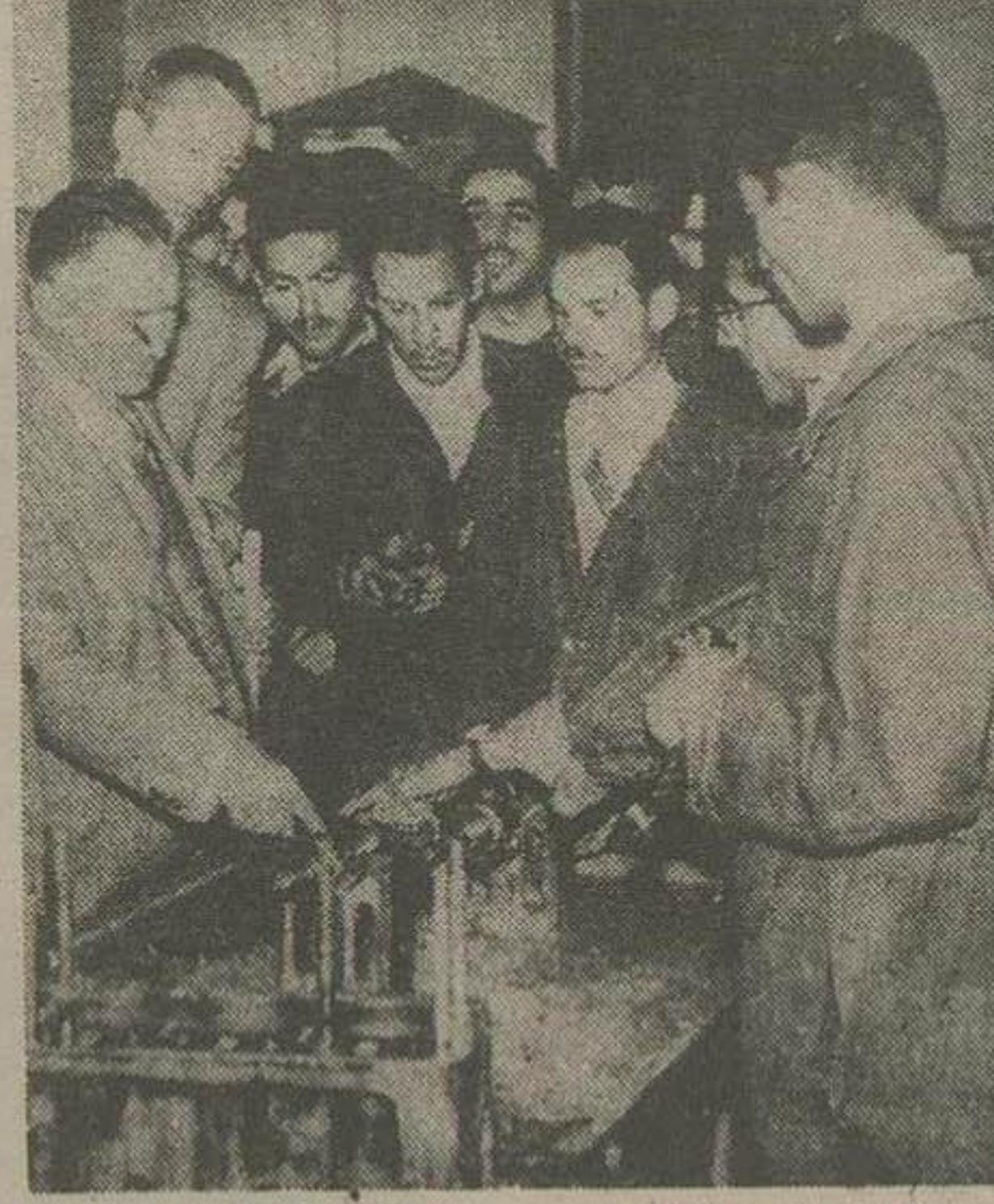
کارآموزان هنگام پیاده و سوار کردن موتور هواپیما
