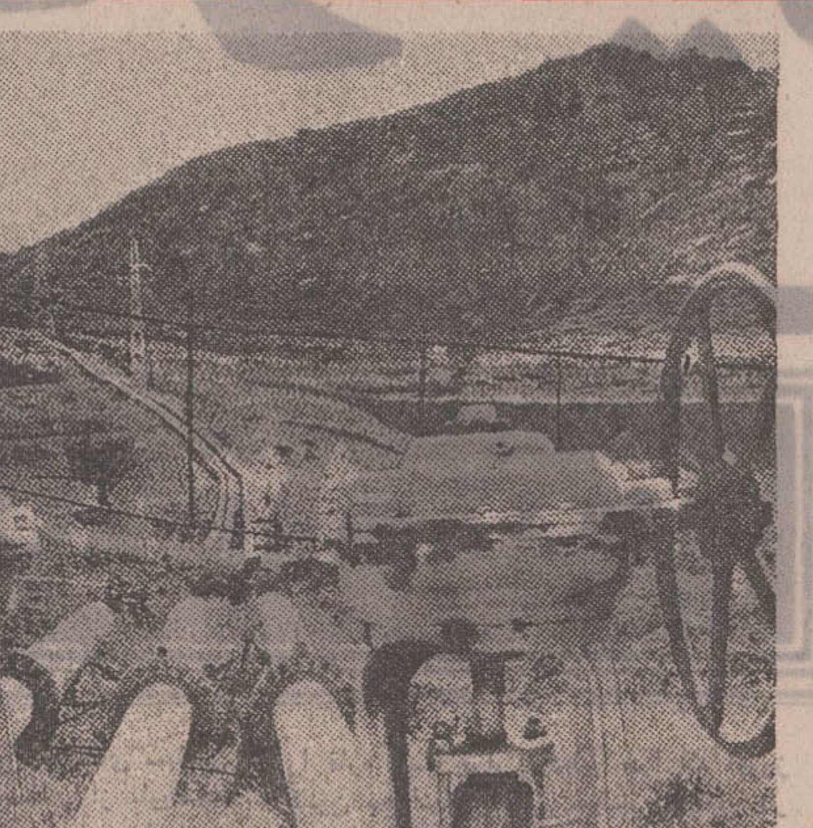
این یک عکس تاریخی و کمی نظیر است. عکس از ساختمان اولین خط لوله نفت مسجد سلیمان - آبادان که در سال ۱۲۹۱ به پایان رسید.
