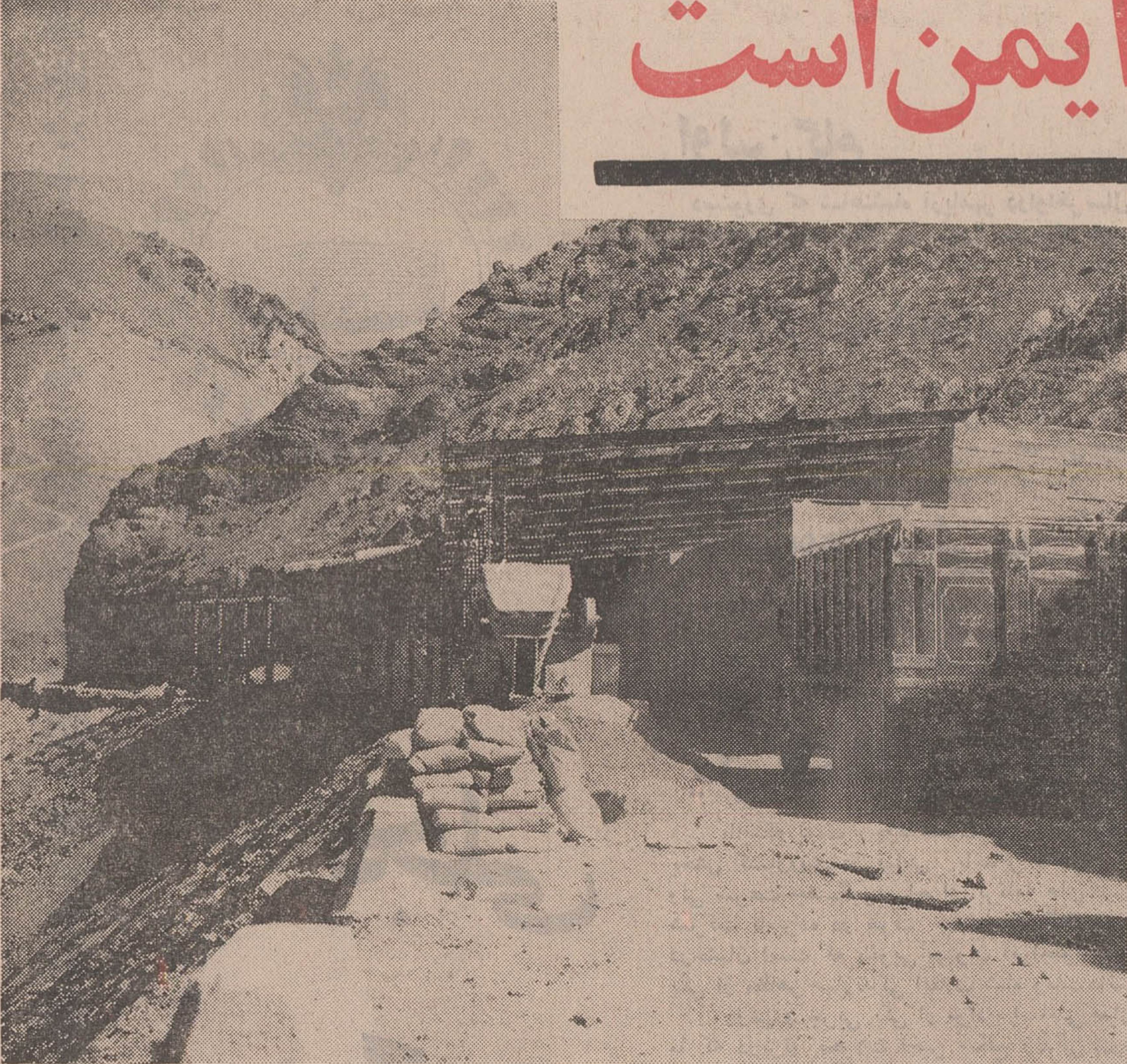
در دو طرف تونل کندوان در نقاط بهمن گیر گالری ساخته شده و این گالری هاراه را در زمستان برای حرکت بی خطر میکند.
