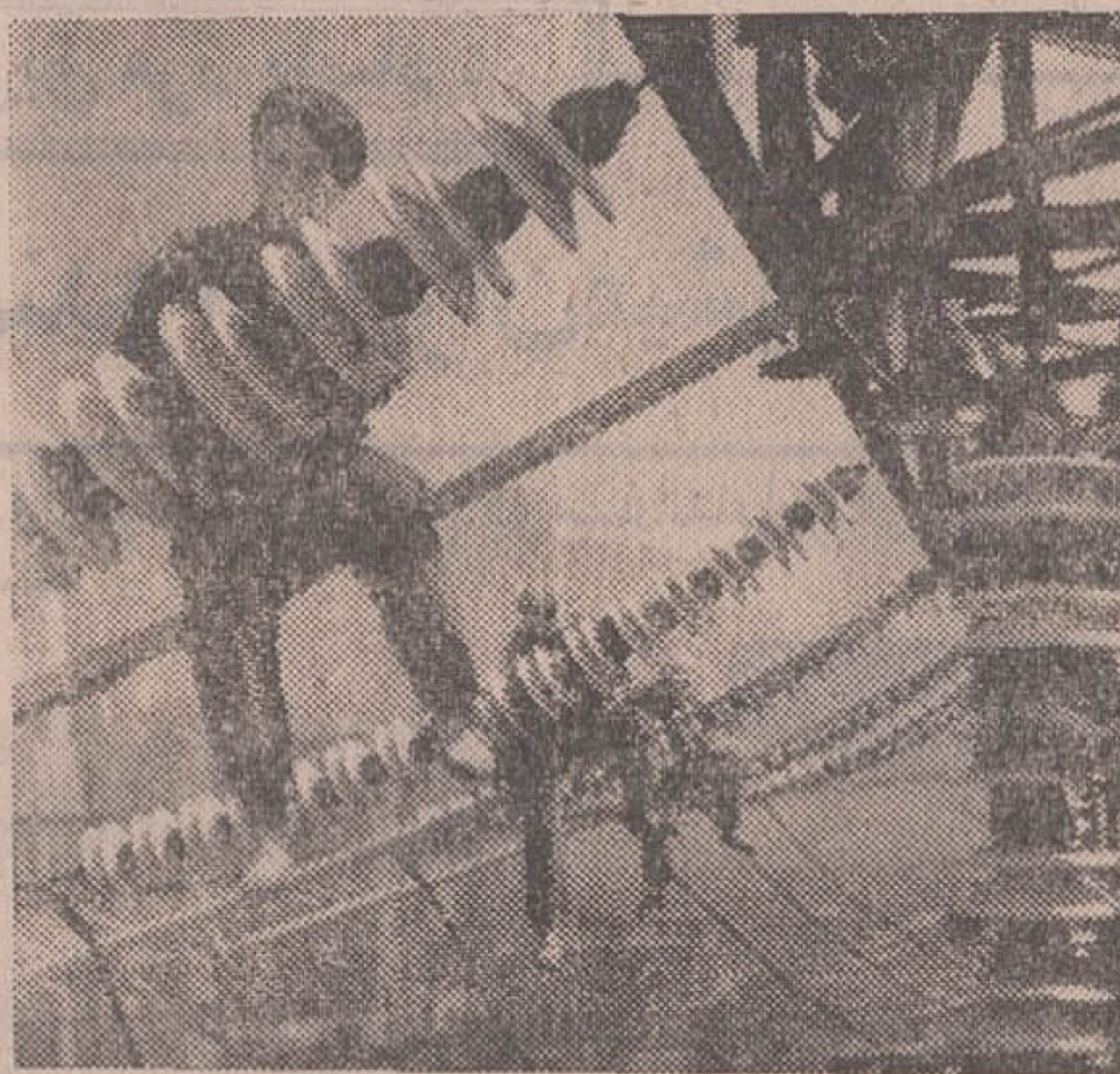
چندن از زنان چینی درحال کتیدن يك خط فشار قوی برق
