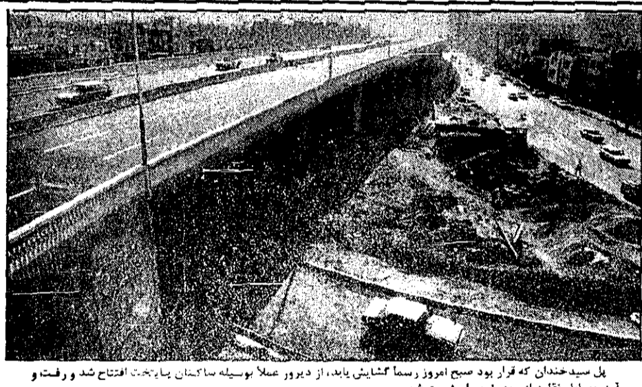
پل سید خندان که قرار بود صبح امروز رسماً گشایش یابد، از دیروز عملاً بوسیله ساختمان باریخت افتتاح شد و رفت و آمد وسایل نقلیه از روی این پل شروع شد.
