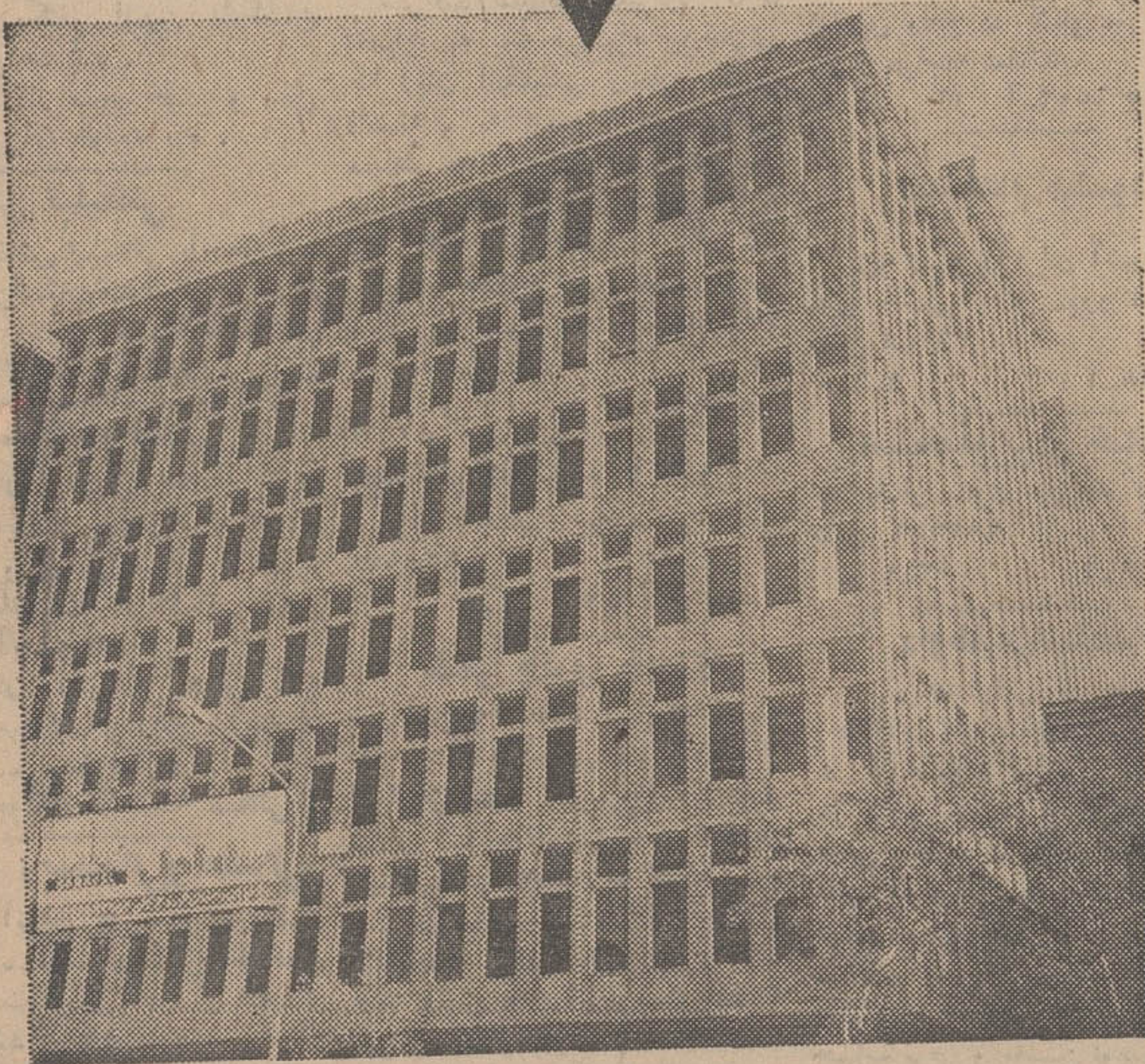
ساختمان آقای احمد صافی واقع در خیابان شیران قدیم با سیستم تهویه مطبوع
