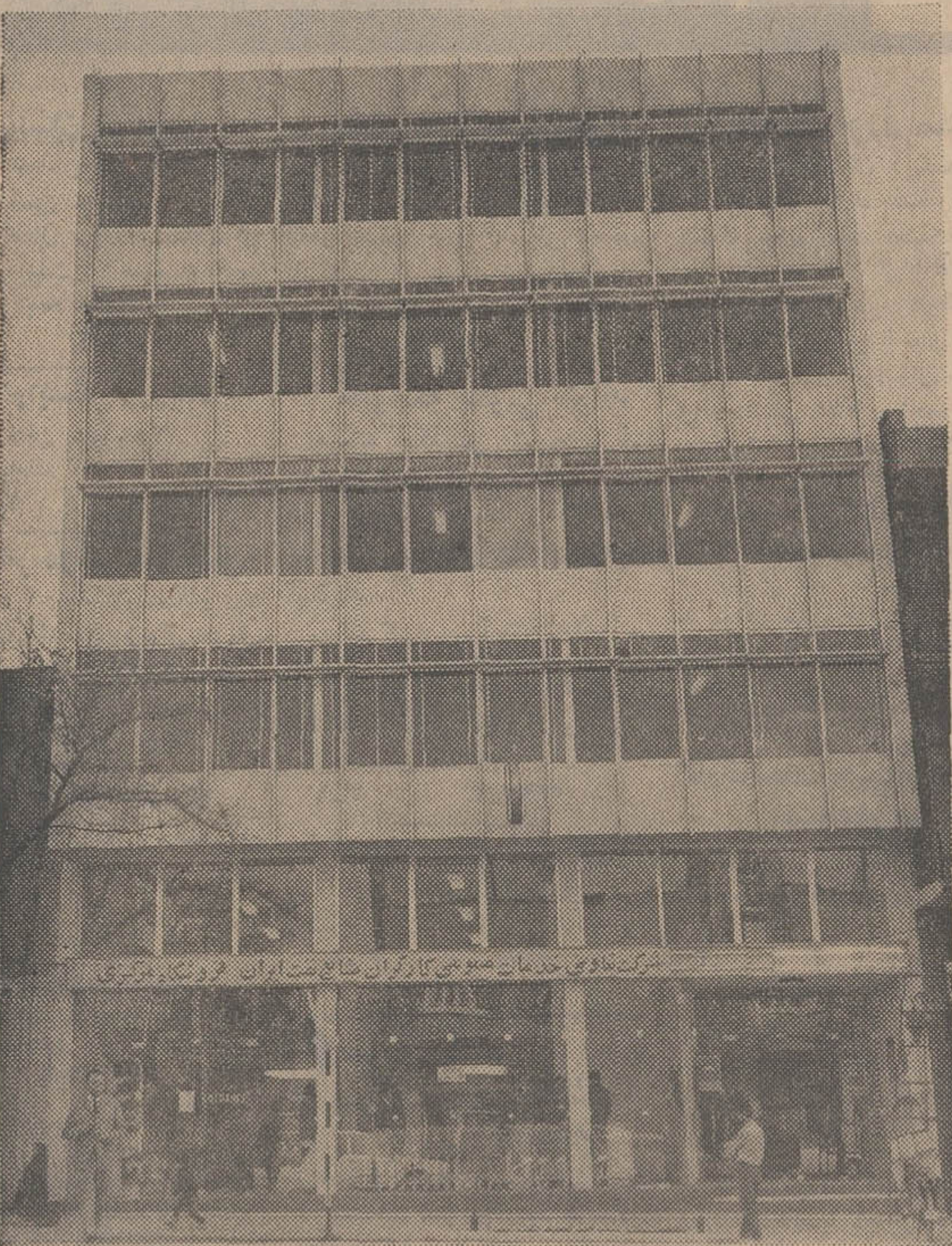
ساختمان آقای حسین صافی واقع در خیابان بهجت آباد اوایل سال ۱۳۴۷ با سیستم تهویه مطبوع
