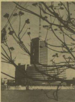
ساختمان رادیو تلویزیون قاهره
